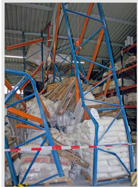
Regaleinsturz in Wunsiedel (Quelle: THW Marktredwitz)
